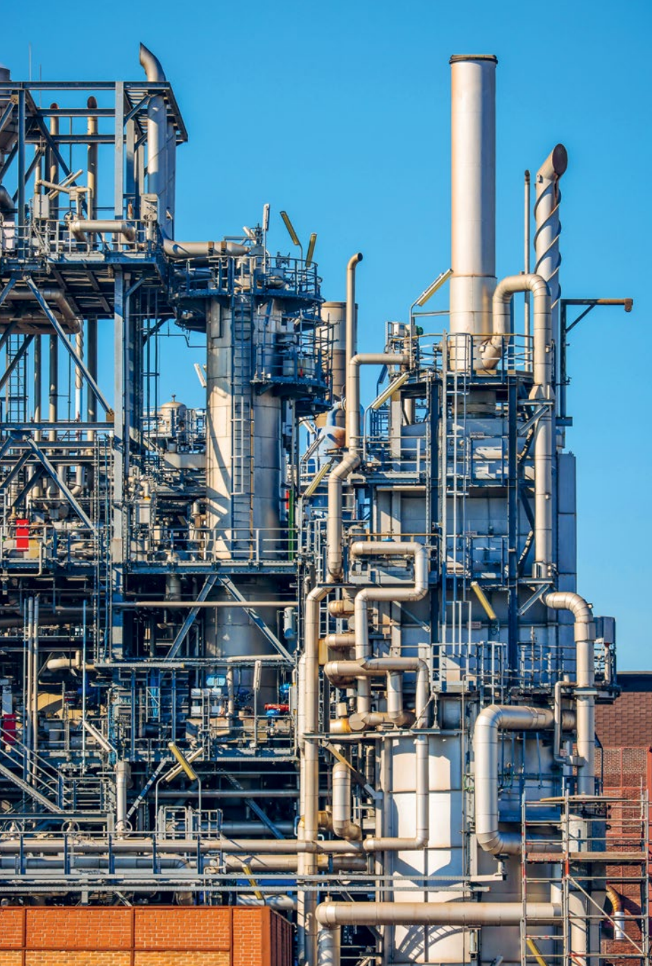
In Oberhausen (D) wird auf herkömmliche Art sogenannter grauer Wasserstoff aus fossilen Brennstoffen gewonnen. Daneben entstehen aber noch andere Produkte. Foto: Rupert Oberhäuser / Keystone
