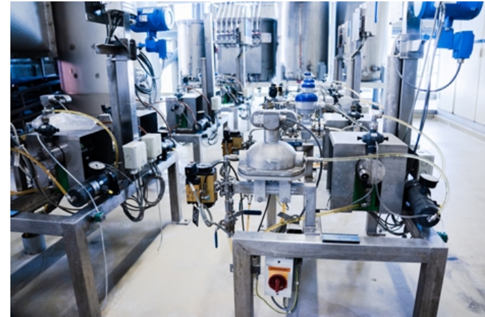
Tanks und Dosierpumpen
